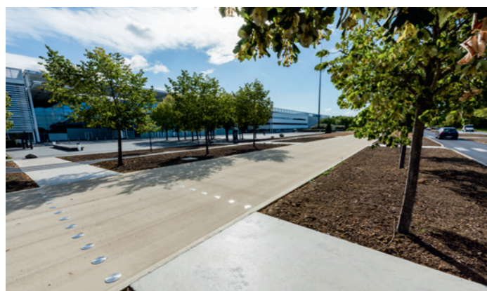
Plateforme du Tzen 2 (Carré Sénart à Lieusaint)
