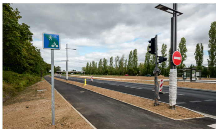
Cheminement pour piétons et cyclistes (Savigny-le-Temple)
