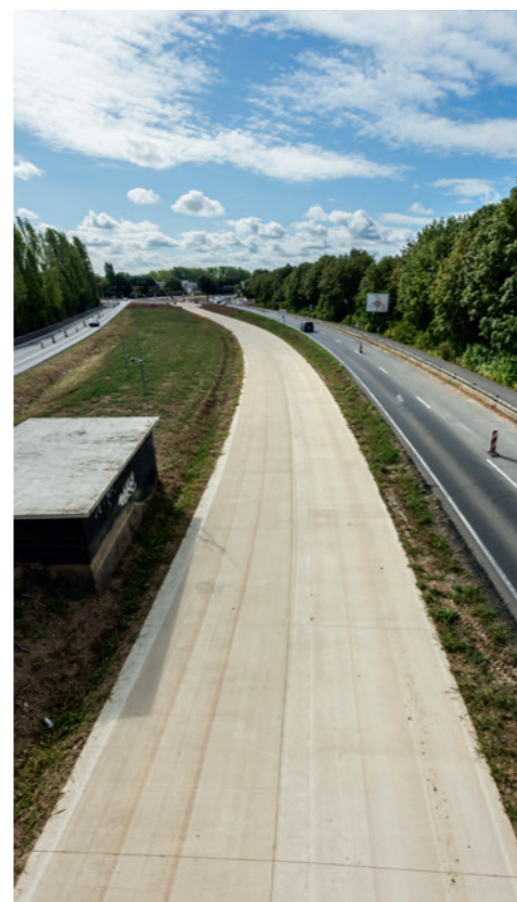
Plateforme du Tzen 2 vue du pont de l'avenue des forêts (Savigny-le-Temple)
