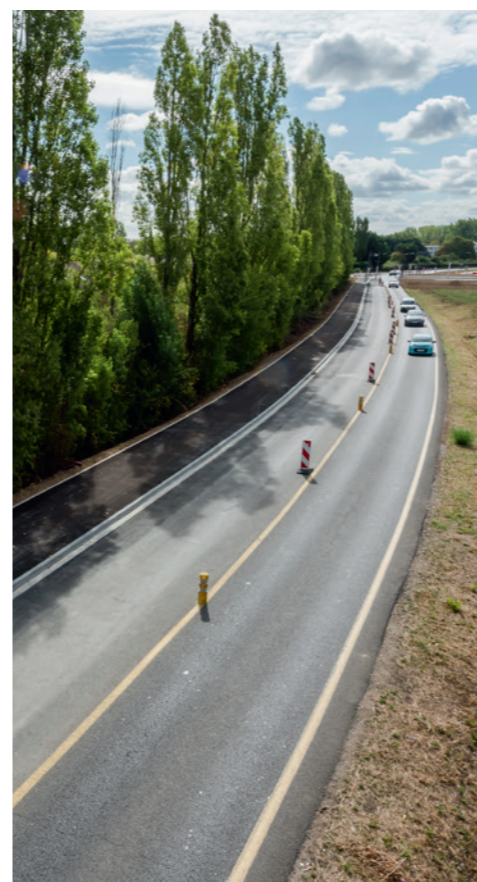
Cheminement pour piétons et cyclistes (Savigny-le-Temple)
