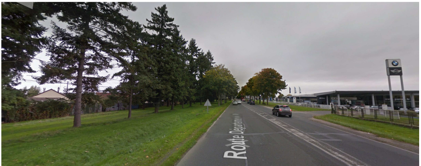
Figure 2 : Aperçu du site au niveau de la zone 1 (le long de la RD306)
